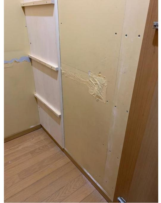
上下の棚を外し、用意しておいた棚取付用棧を付けた左右の側板を張り付けた。構造上、この時点で内側に倒れなければOKぐらいなので、壁への取付は留める程度で良い。
